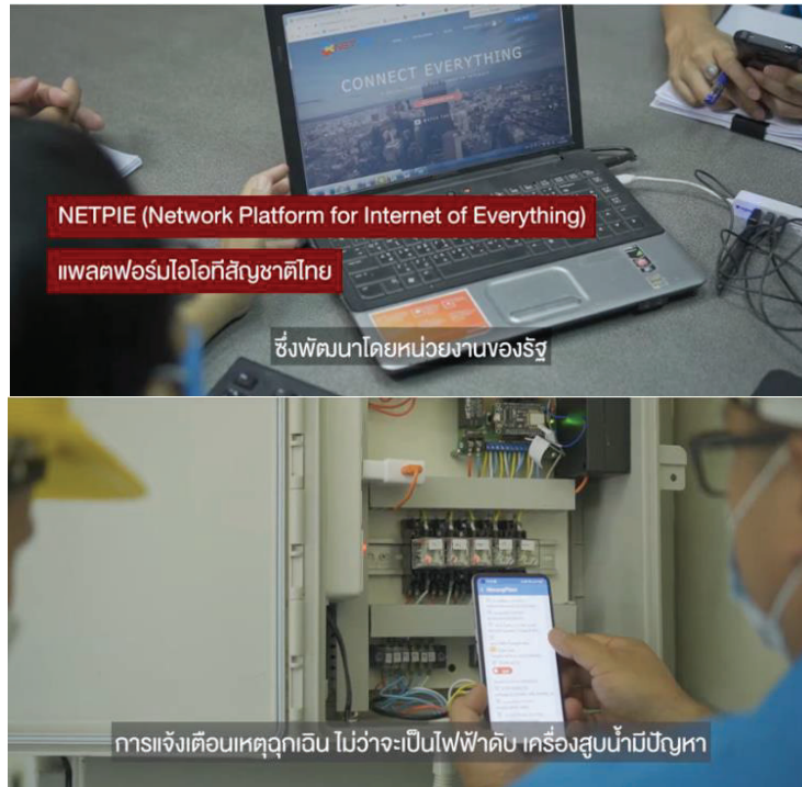
ภาพที่ 4-23 การตรวจวัด/ควบคุมแจ้งเตือนผลิตน้ำอัจฉริยะด้วยระบบ Smart IoT and Sensors ที่มา วลัยลักษณ์ คงพระจันทร์ (2564) ศูนย์เทคโนโลยีอิเล็กทรอนิกส์และคอมพิวเตอร์แห่งชาติ กปภ. เชียงใหม่
