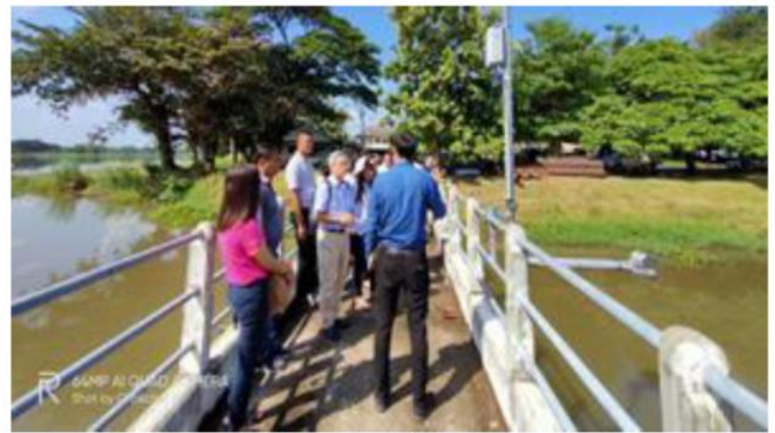
ระบบวัดเซ็นเซอร์ระดับน้ำอัตโนมัติกลางคลอง สายหลัก คบ.ท่อทองแดง
