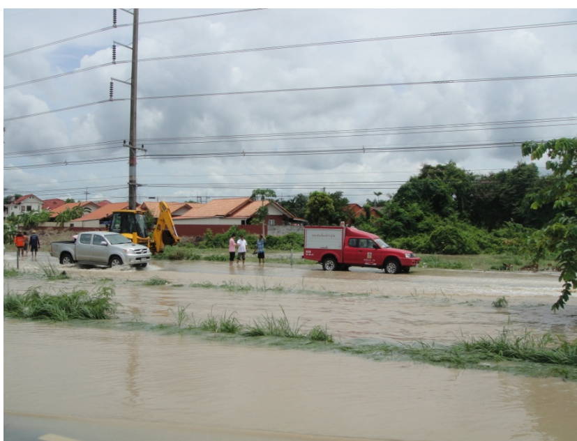
รูปที่ 3.8-3 พื้นที่น้ำท่วมบริเวณถนนสุขุมวิท
