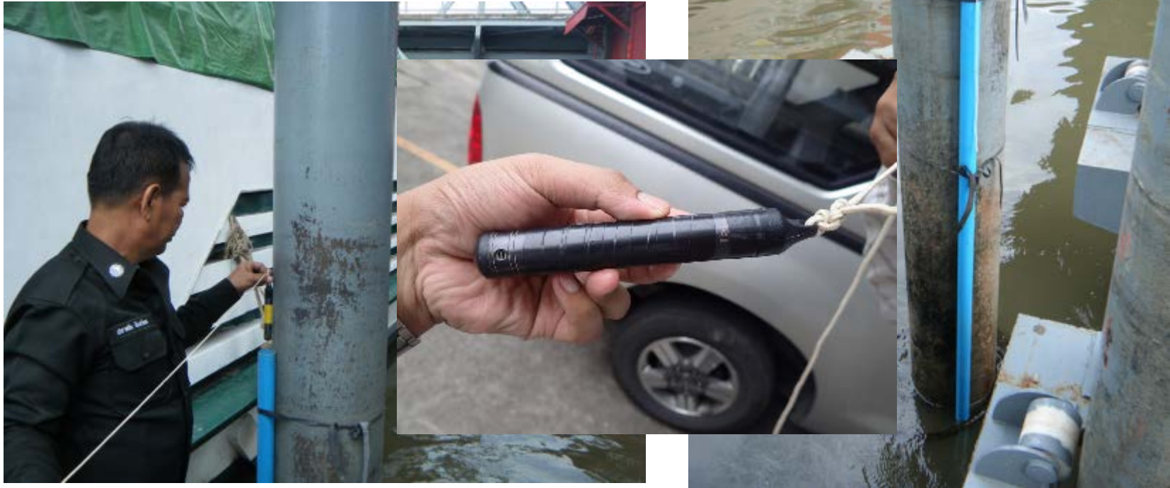
การติดตั้งอุปกรณ์บันทึกระดับน้ำ
