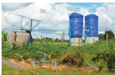
แปลงกลุ่มเกษตรกร นายประจวบ ชำแป บ.เสาลำดู่ ต.กุดเพียขอม อ.ชนบท จ.ขอนแก่น ก่อสร้างเมื่อวันที่ ๙ มิถุนายน ๒๕๖๐
